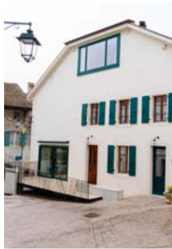
L'auberge communale sera un des bâtiments raccordés au futur chauffage à distance.
